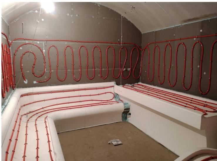
При изготовлении лежаков и сидений обязательно учитывается обогрев изделий, который представляет собой единую систему с теплым полом. Поэтому перед установкой мебельного гарнитура делаются углубления под теплый пол. При использовании электрического отопления проводятся каналы для кабеля шириной 25 мм, для водной системы каналы под трубопровод — 40 мм.
