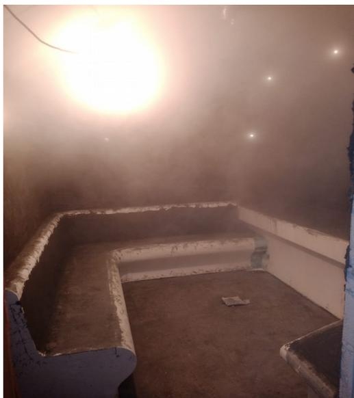
Армирование лежаков, сидений и массажных кушеток проводится фасадной сеткой из стекловолокна, устойчивой к воздействию агрессивных щелочей. Данный материал имеет высокую плотность с показателями не менее 145 гр/кв.м. Заливка осуществляется клеевым раствором. Можно использовать марку любого производителя, главное, чтобы фиксация была надежной.
